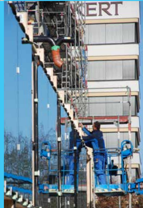
oben: Einsetzen der Scheiben mit Hilfe eines Steigers
