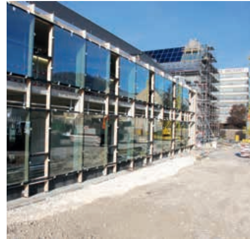
links: Vorbereitung der Wärmeschutzgläser zum einfügen in die Fassade
